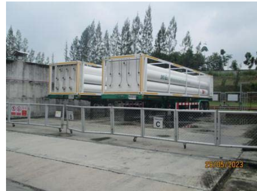
รูปที่ 3-60 สถานที่ติดตั้งระบบสำรอง ก๊าซไฮโดรเจน
