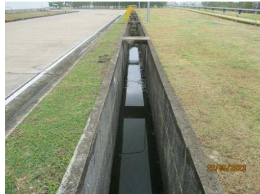
รูปที่ 3-17 ท่อระบายน้ำเสียและรางระบายน้ำฝนของโครงการ
