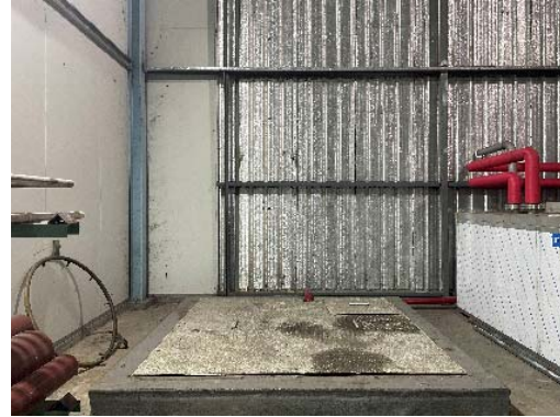
รูปที่ 3-26 บ่อรวบรวมสารละลายโครเมียม จากชุดอุปกรณ์ชุบเคลือบลูกรีดเพื่อการซ่อมบำรุง
