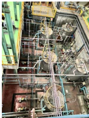
รูปที่ 3-27 บ่อรวบรวมสารละลายโครเมียม จากกระบวนการเคลือบผิว
