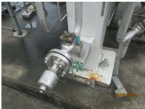
รูปที่ 3-61 อุปกรณ์กักเก็บและลำเลียง ต่อเข้ากับระบบสายดิน
