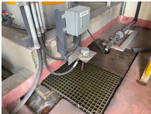
รูปที่ 3-54 Emergency Drain
